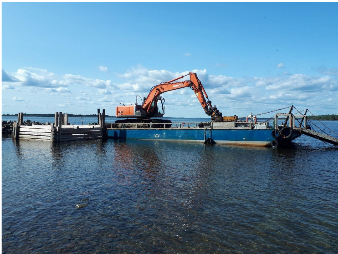
Farledsföreningen fyllde på stenbärarna i karet 2019-08-10 med ytterligare 1,0 ton sten samt placerade två plastbehållare med ca 2 ton vatten ovanpå karet för att säkra karet till dess att det stabiliserats.
